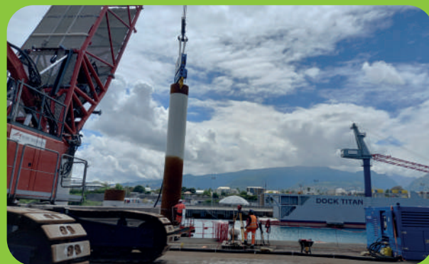
Battage des pieux d'amarrage du dock, en décembre 2025. © BG
