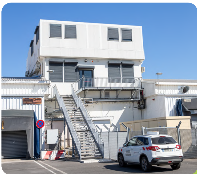
La capitainerie annexe domine le quai Guézé.
