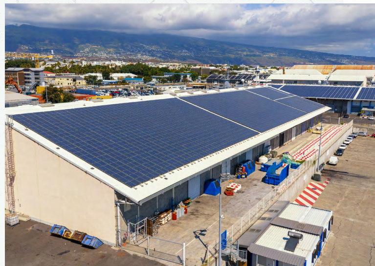
Installation de panneaux photovoltaïque en toiture au Port Ouest.
